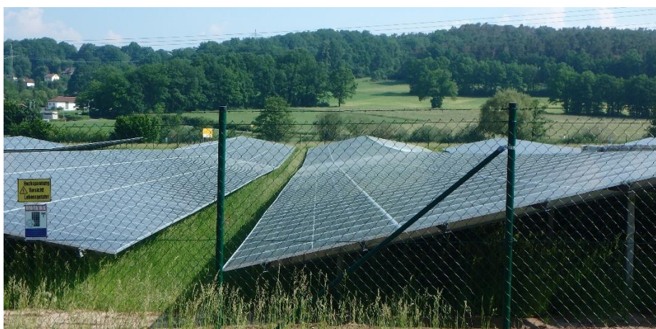
Abbildung 1: Beispiel einer Ost-West-Anlage
